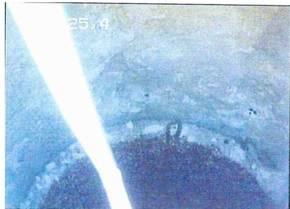
*Partie recouverte de buses ciment entre 26.5 et 31 m*
