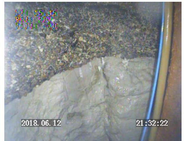
**4<sup>ème</sup> palier (46.7 m<sup>3</sup>/h) - Prof 15.45 m : base du cuvelage béton dénoyée / fractures dans la craie suintantes**
