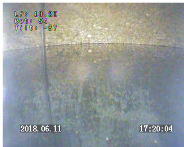
Prof 13.20 m : vue sur la surface piézométrique / eau claire / parois du cuvelage en béton propres
