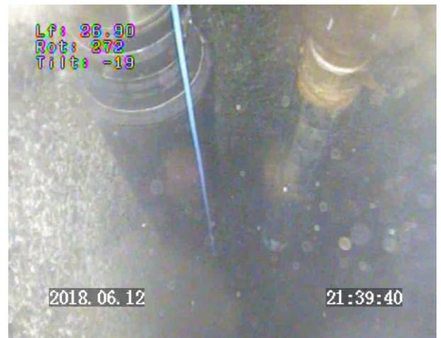
**4<sup>ème</sup> palier (46.7 m<sup>3</sup>/h) - Prof 26.90 m : pompe d'exploitation n°1 et pompe d'essai / eau légèrement turbide**
