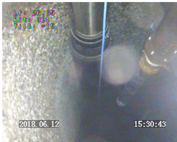
1<sup>er</sup> palier (11.5 m<sup>3</sup>/h) - Prof 28.85 m : pompe d'exploitation n°1 et pompe d'essai
