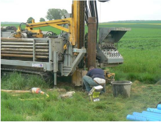
Foreuse et pose du tubage acier en 244 mm
