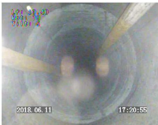
Prof 13.40 m : vue axiale sur la base de la première portion du cuvelage en béton
