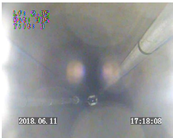
Prof 2.05 m : début de l'inspection / vue axiale sur le cuvelage en béton Ø 1550 mm / colonnes de refoulement des deux pompes
